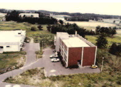
▲5 第2食堂・電子計算機センター棟
