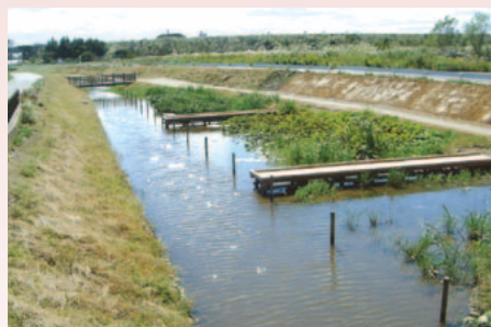
清五郎排水路下流部
