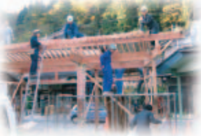
(上)工学力教育センターの概観 (右)住民と学生の協働による雁木の建設
